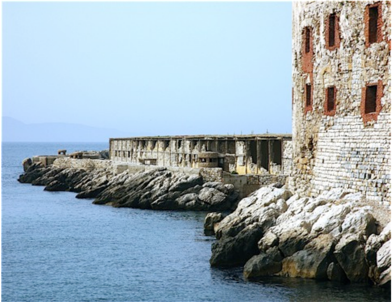
Particolare della Colombaria: a destra le finestre di alcune celle. Sullo sfondo, i segni del degrado in cui versa la struttura.
