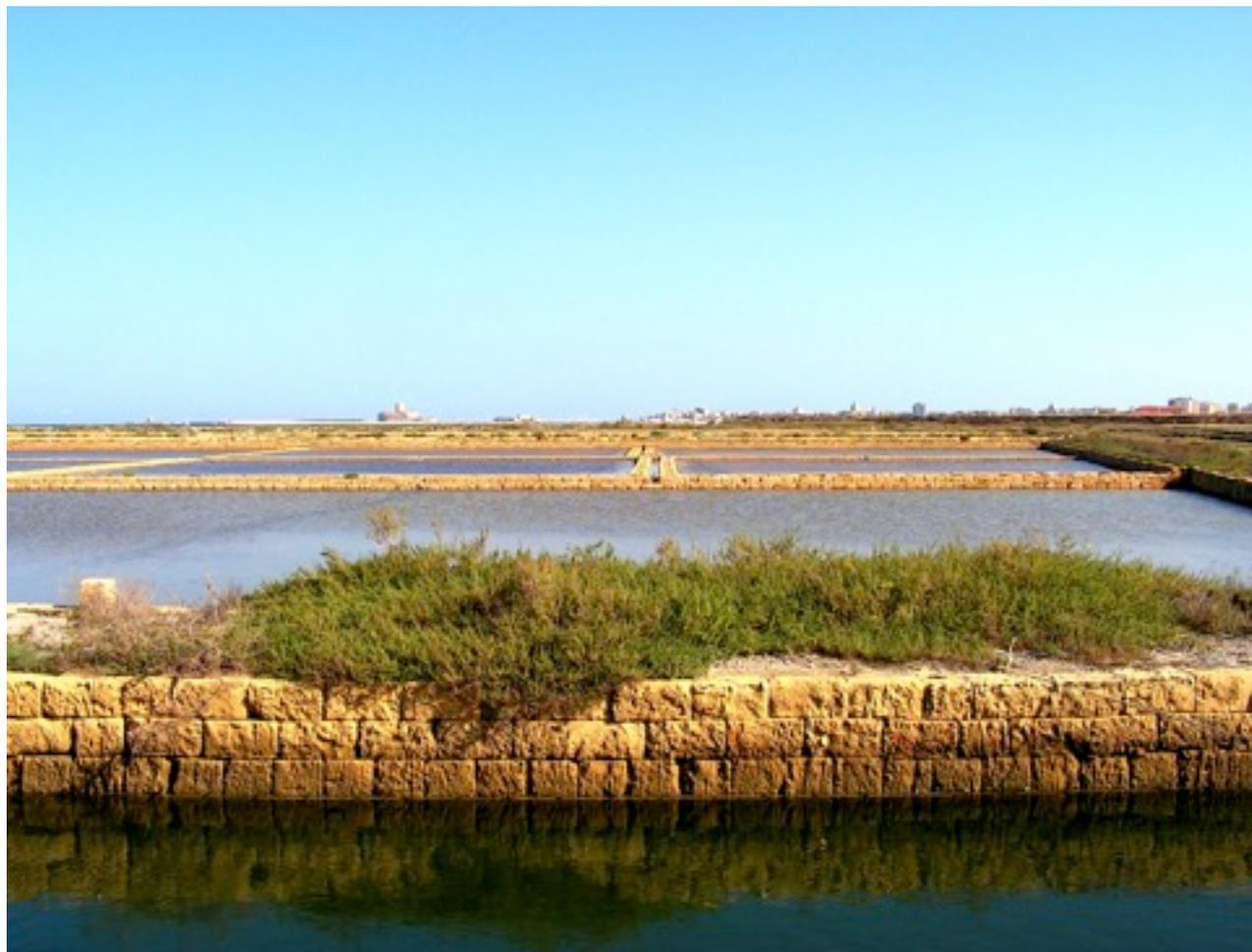
Nella foto, una visione panoramica delle vasche delle saline. A una distratta osservazione sembrano essere tutte uguali: in realtà ogni vasca ha delle caratteristiche proprie e a ogni rettangolo corrisponde una diversa fase del processo produttivo.
